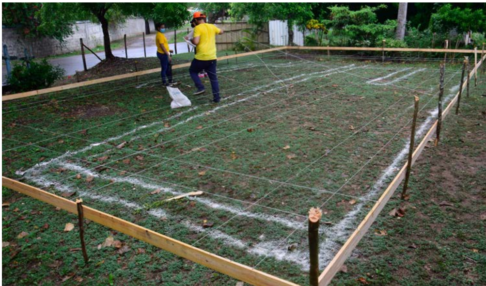
Taller de Construcción Práctica de construcción de una charrancho.
