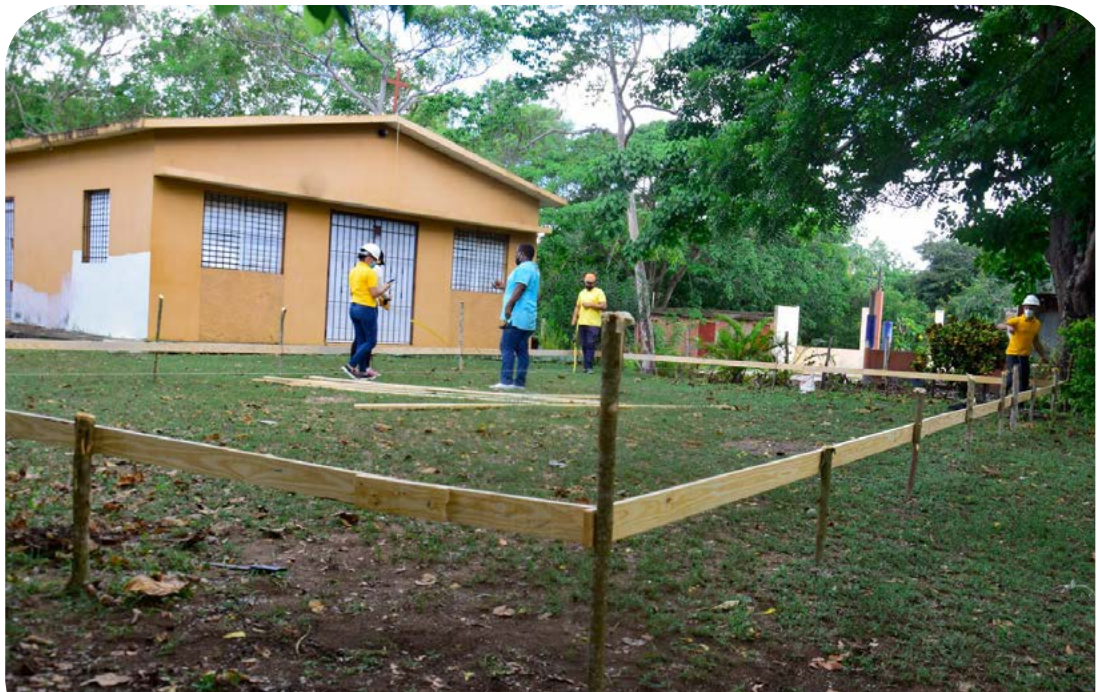
Taller de Construcción Práctica de construcción de una charrancho.
